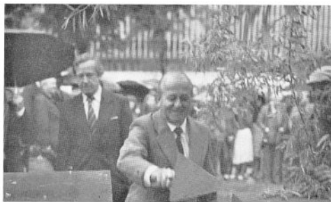
Wmurowanie aktu erekcyjnego rozbudowy gmachu BG (1984)
