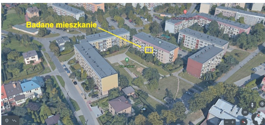
Rys. 1. Usytuowanie budynku ze wskazaniem badanego pomieszczenia Źródło: opracowanie własne z wykorzystaniem Google Earth
