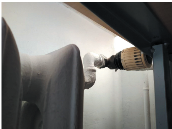
Rys. 19. Widok I na głowicę termostatyczną grzejnika członowego i jej okolice
