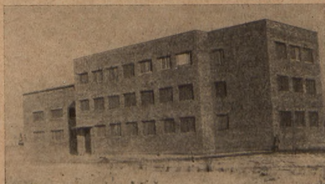
Nowy gmach w trakcie budowy.
