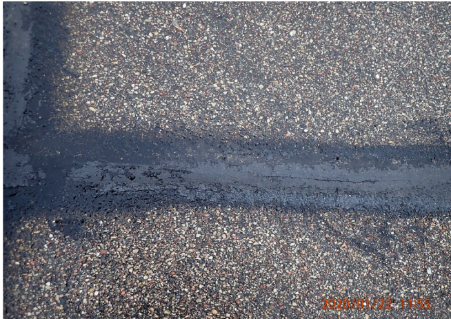
Rys. 16. Miejsce naprawy warstwy mineralno-asfaltowej obiektu do składowania odpadów (źródło własne).
