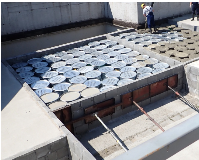
Rys. 18. Operacja betonowania odpadów w celu ich składowania w obiekcie nr 8 (źródło własne).
