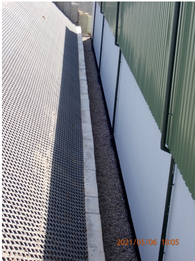
Rys. 17. Przebudowana skarpa obiektu nr 8a oraz drenaż odwadniający obiekt (źródło własne).
