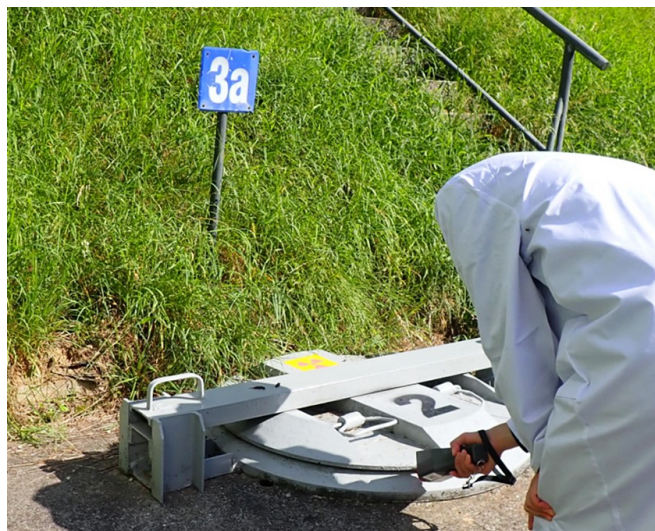
Rys. 11. Pomiar mocy dawki na powierzchni włazu obiektu do składowania zużytych zamkniętych źródeł promieniotwórczych (źródło własne).
