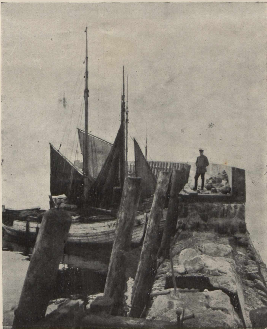
Przebudowa portu zachodniego w Helu.
