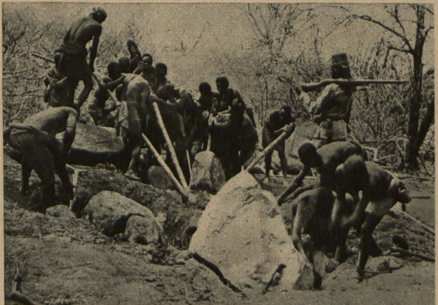
Niwelowanie terenu pod budowę kolei w Kongo Francuskim
