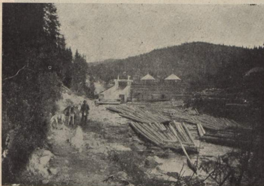
Jaz kłauzy Łostun. Na pierwszym planie przygotowana do odpływu „daraba”. Fot. H. Gąsiorowski.
