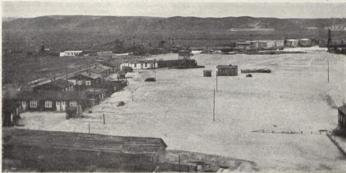
Z lewej strony widać stłaki taboru pogłębiającego. W środku obok kanału żelbetowe skrzynie do nabrzeży. Z prawej zapoczątkowane roboty przy
