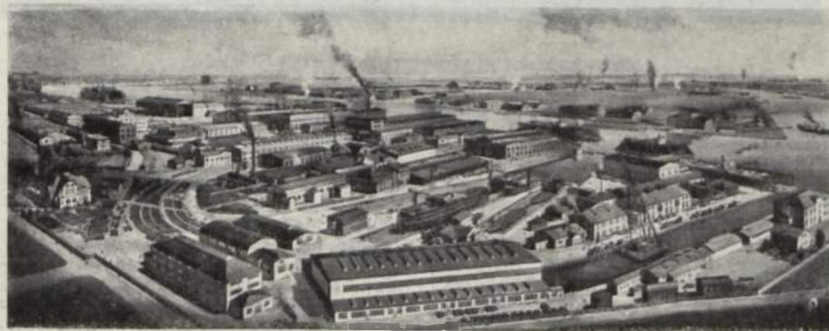
Ogólny widok obecnej stoczni gdańskiej.
