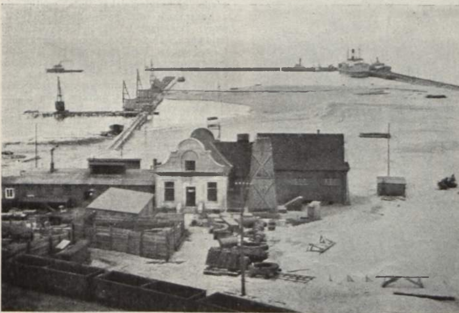
Budowa nabrzeży przy molo południowym i zasypywanie przyległych terenów portowych. Fot. Wojciechowski.
