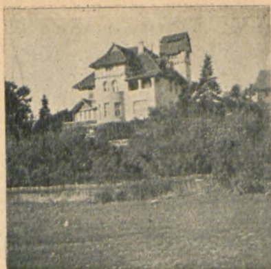
Siedziba Instytutu Różańcowego. Widok od strony Wisły.
