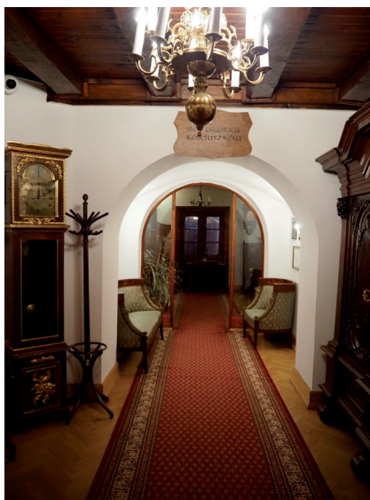
Ryc. 4. Zachowany układ sieni z XVIII w., podzielonej na 3 części. Zdjęcie zrobione od strony wejścia z ganku. Widoczne grube ściany z łukami stanowią podpórę ogromnego komina.
