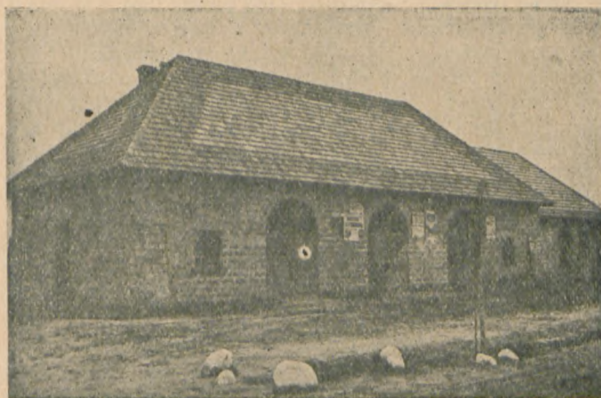
Budynek straży pożarnej ochotniczej w Czarnocinie pow. łódzkiego wybudowany w 1928 roku
