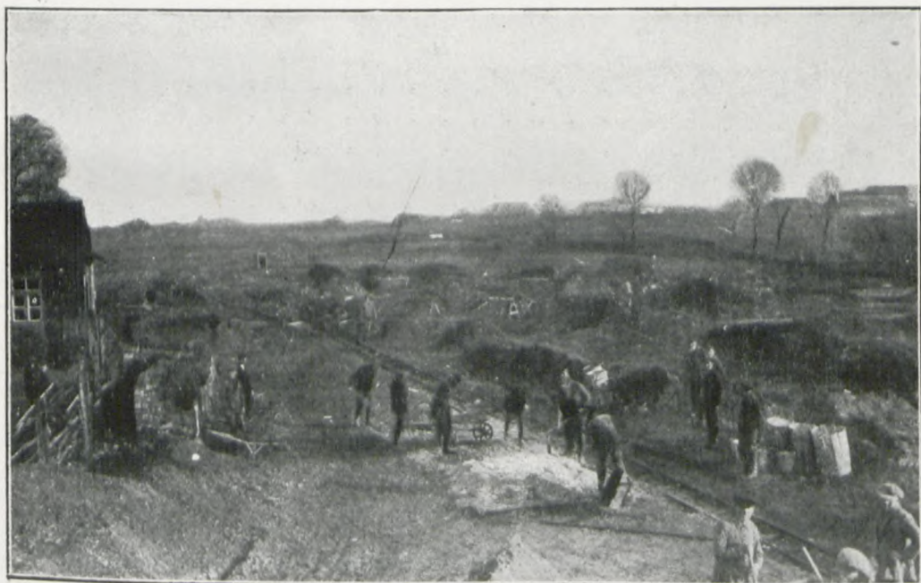
Fot. 3. Radom. Budowa rzeźni. (str. 131).
