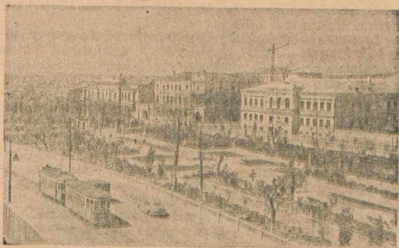
Odbudowane ulice Stalingradu w miejscu zniszczonych.
