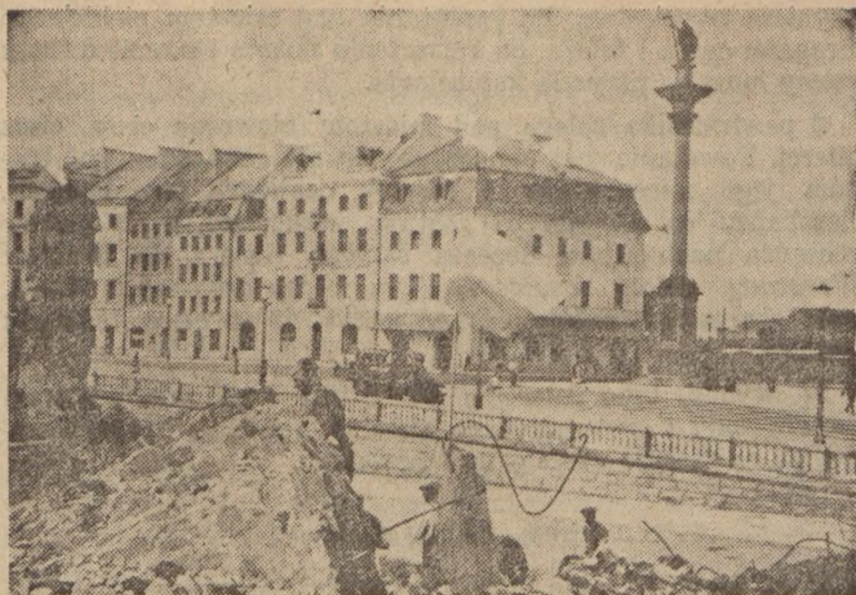
Odbudowane domy i kolumna Zygmunta na placu Zamkowym.
