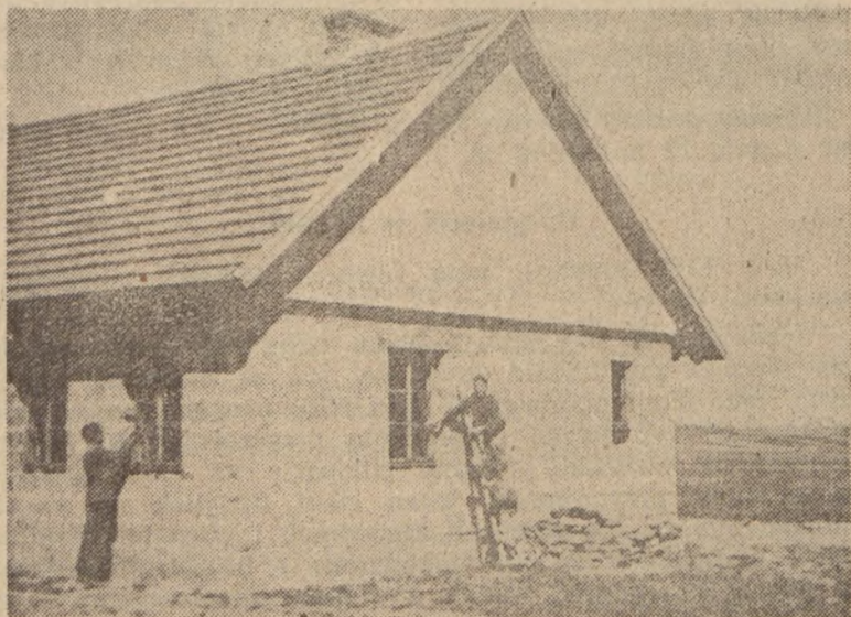
Wykańczanie domu mieszkalnego (gromada Pielnia, pow. Sanók).
