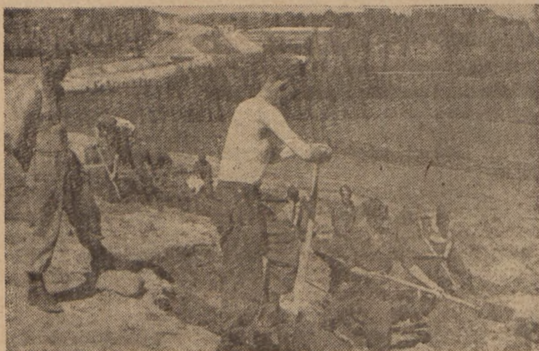
Prace Junaków S. P. przy niwelacji terenu pod autostradę Gdańsk — Gdynia.
