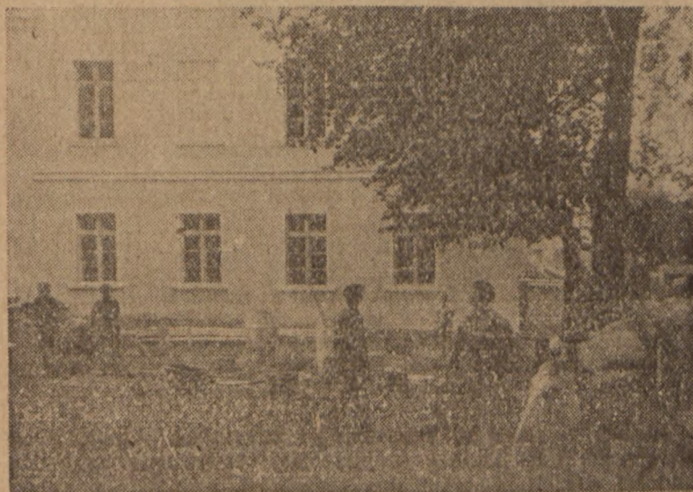
Wykańczanie budowy Ludowego Domu Kultury w Spółdzielni Produkcyjnej w Szczawienku.
