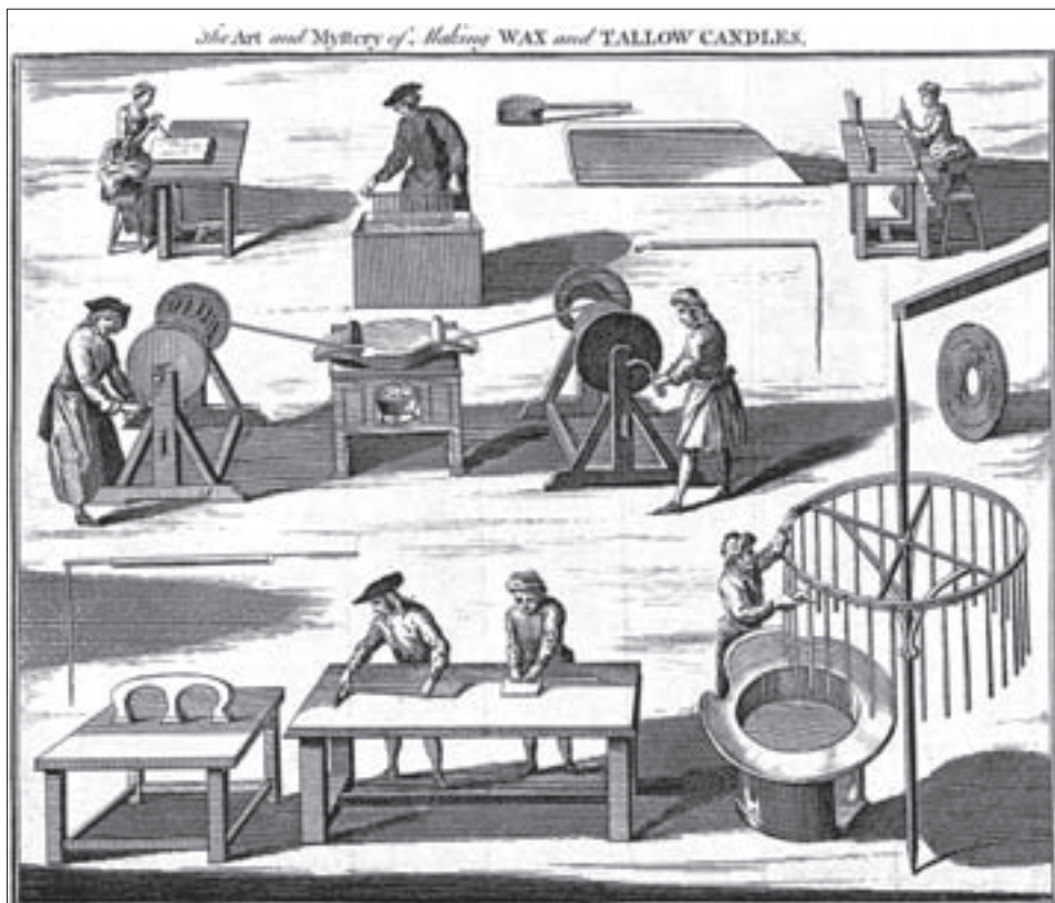
Il. 1. Na ilustracji przedstawiono różne sposoby wyrobu świec, XVIII w. Źródło: Various Stages in the Process of Candle Making and Machinery Used. Engraving, [between 1700 and 1799], https://wellcomecollection.org/search/images?query=npq52ypp# [dostęp: 17.05.2024].
