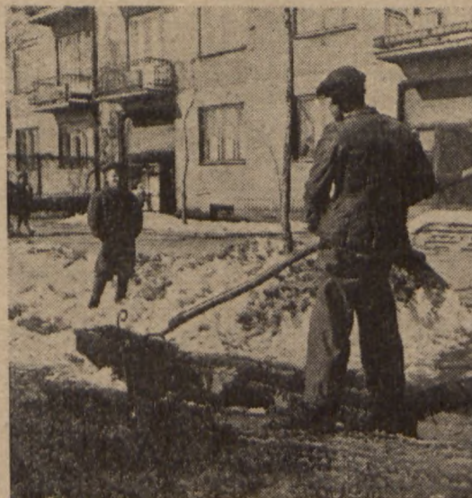
Czyszczenie kanału wodnego przez Wydział Wodno-Mel. w Warszawie
