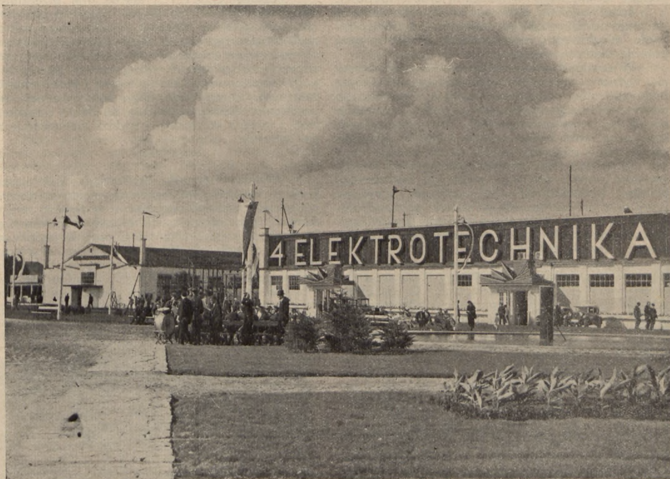
Fragment Wystawy Przemysłu Metalowego i Elektrotechniki.
