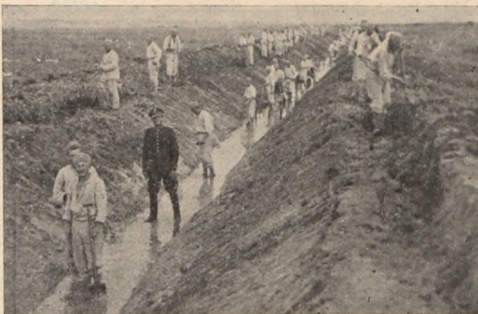
Część pracy już wykonanej.
