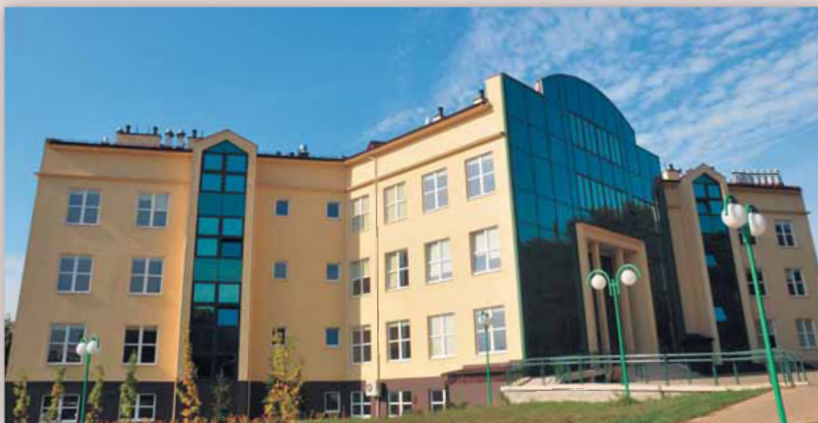
Nowy obiekt Wydziału Nauk o Ziemi i Gospodarki Przestrzennej
