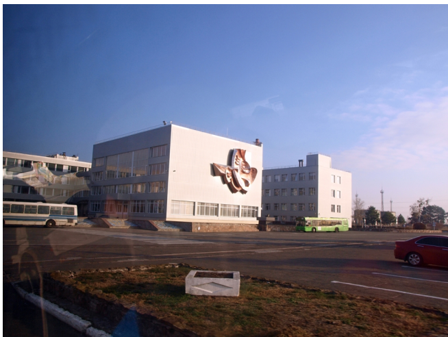
Rys. 3. Plac główny przed elektrownią.
