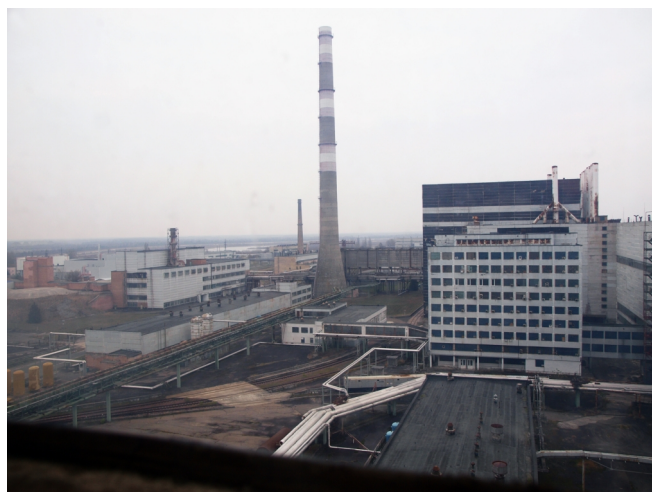
Rys. 4. Widok na kompleks elektrowni (źródło: materiał własny).
