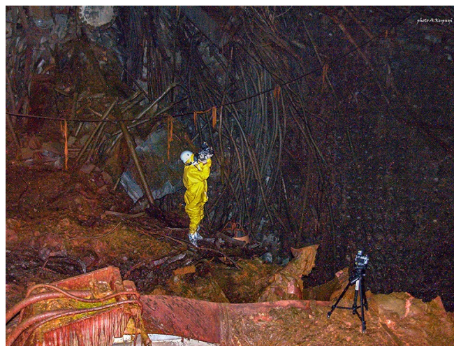
Rys. 9. Hala zniszczonego reaktora numer 4 (źródło: Aleksander Kupnyj).
