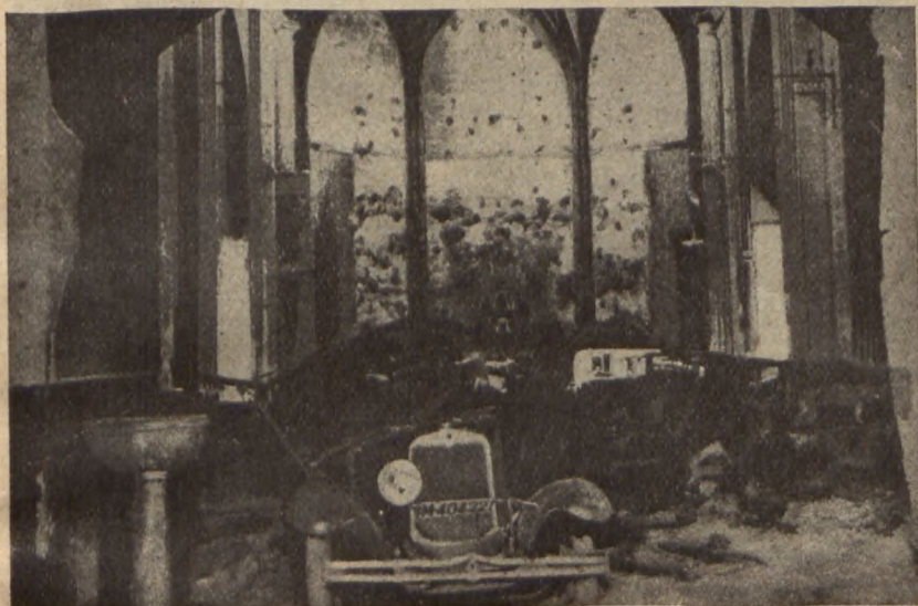
Kościół katolicki w Badajoz zamieniony przez czerwonych na garaż autobusowy, boczne nawy służą za stajnie dla koni.
