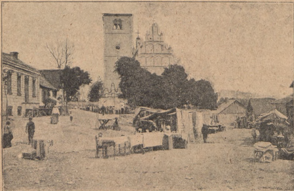
Widok spalonej wieży w Janowcu.
