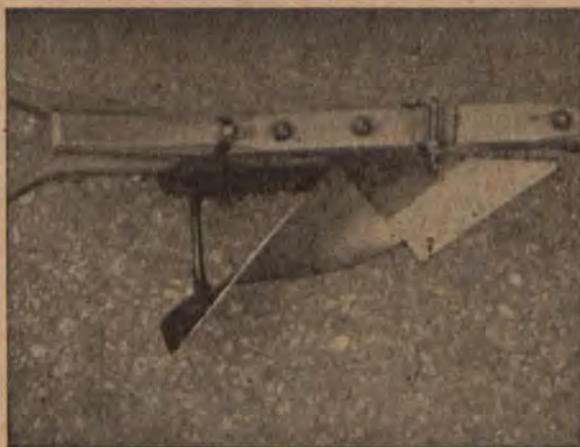
Rys. 3. Odkładnica śrubokształtna.
