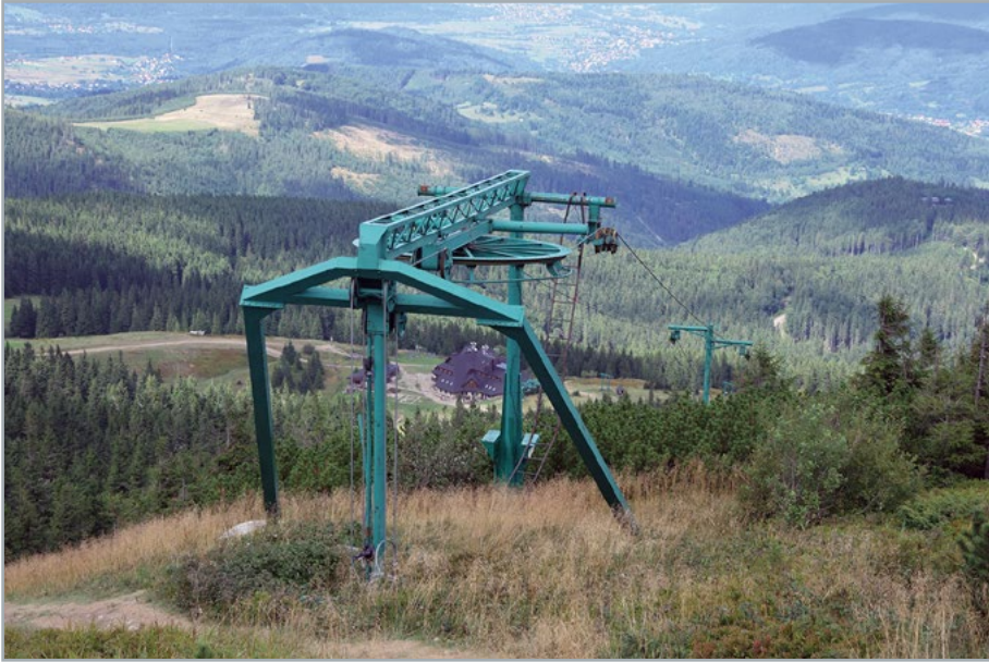
Górna stacja wyciągu zaczepowego nr VII (Hala Miziowa - Pilsko) (fot. 2017)
