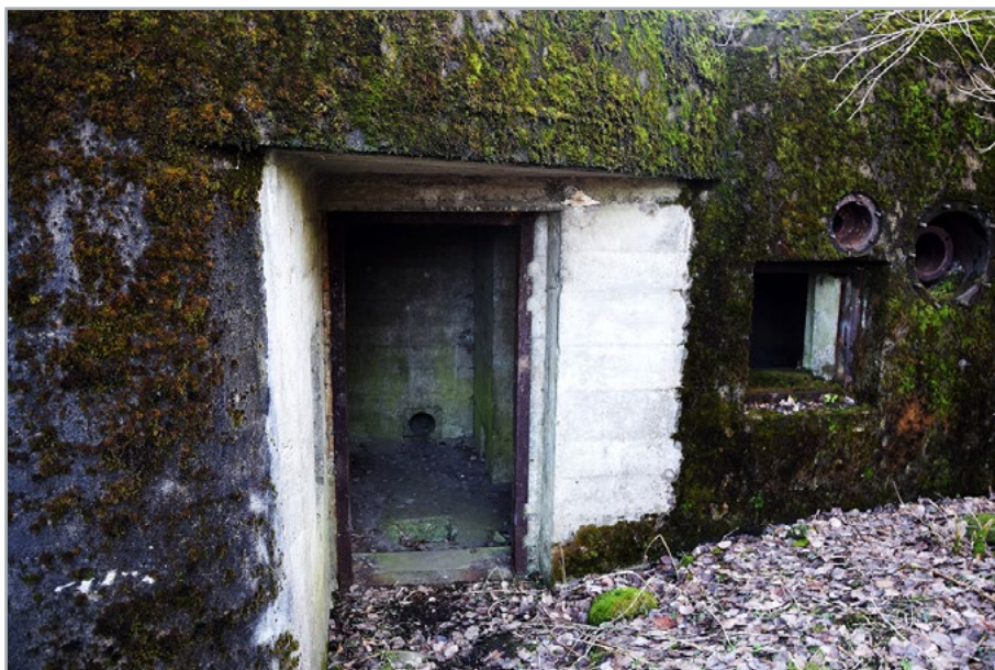
Wejście do fortu K-3 (fot. 2018)
