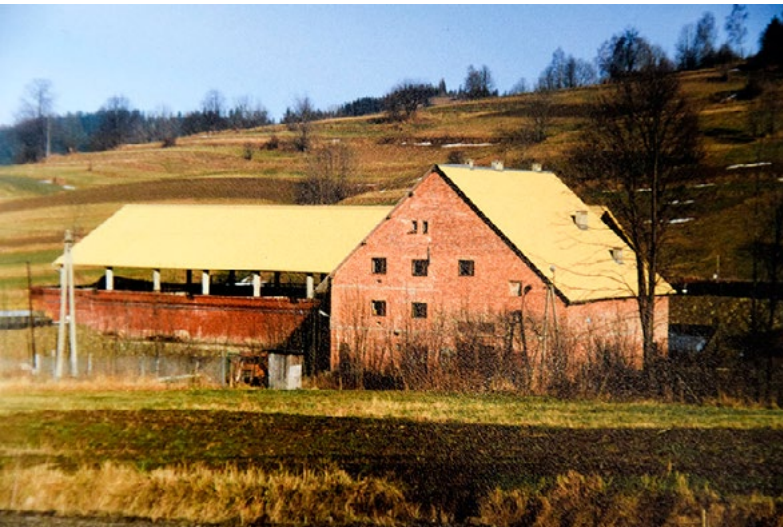
Oczyszczalnia Ścieków w Korbiewie zbudowana w latach 1988–1998 (fot. 1998)
