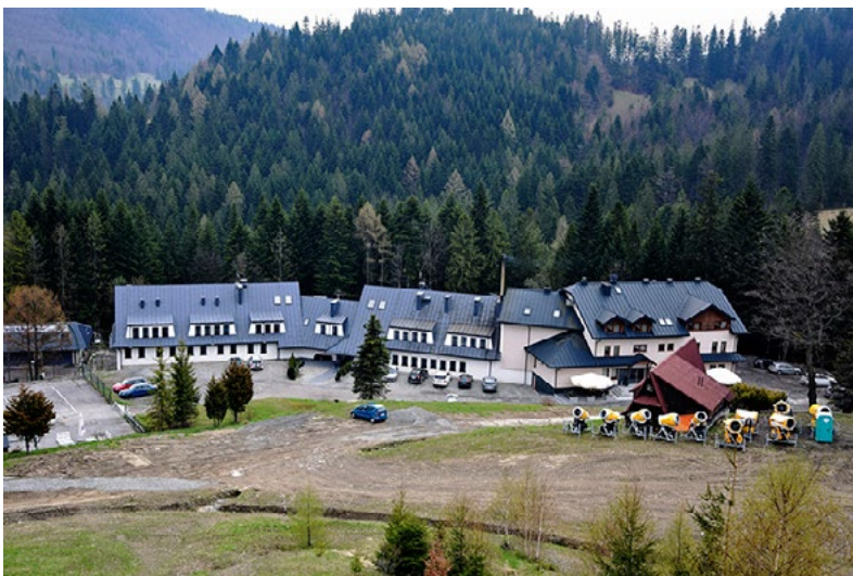
Ośrodek Wypoczynkowy „Pilsko-Jontek” w Korbielowie Kamiennej (fot. 2022)
