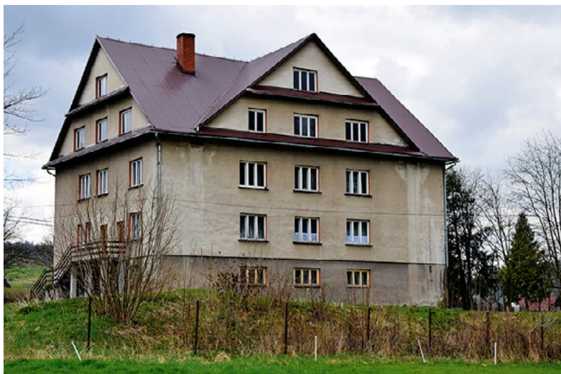
Ośrodek Zdrowia w Krzyżowej zbudowany w latach 1975–1977 (fot. 2017)
