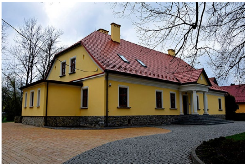
Klasycystyczna plebania w Jeleśni zbudowana w latach 1817–1818 (fot. 2017)
