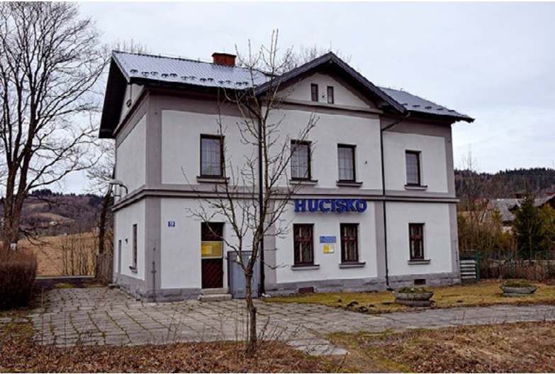
Dworzec kolejowy w Hucisku zbudowany w latach 1881–1884 (fot. 2017)
