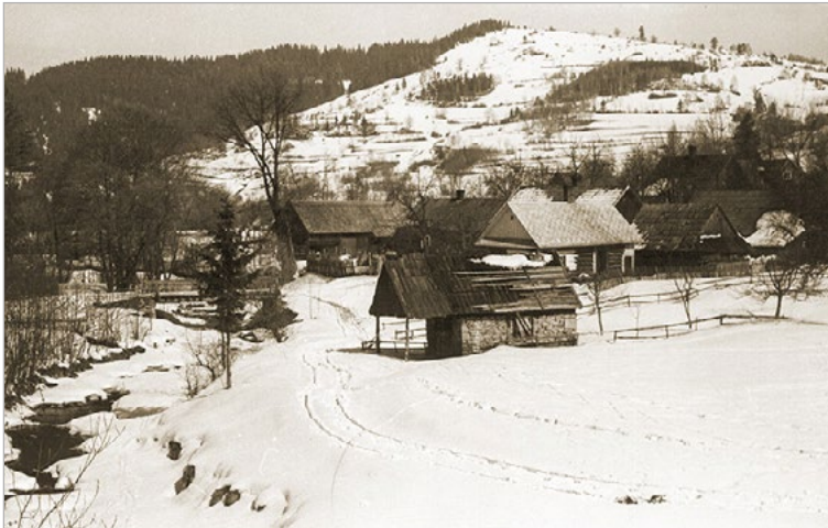
Korbielów Dolny, w głębi Styrk (fot. ok. 1973)
