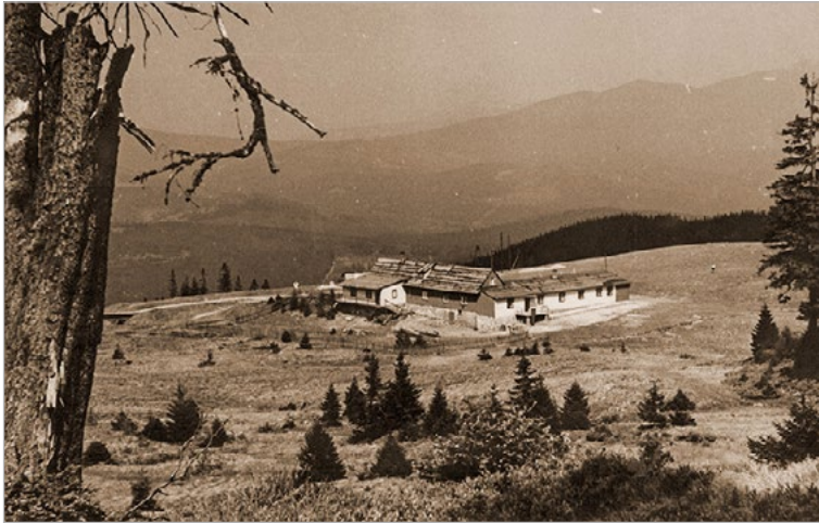
Schronisko PTTK na Hali Miziowej urządzone w dawnym budynku gospodarczym przedwojennego schroniska zniszczonego przez pożar (fot. ok. 1973)
