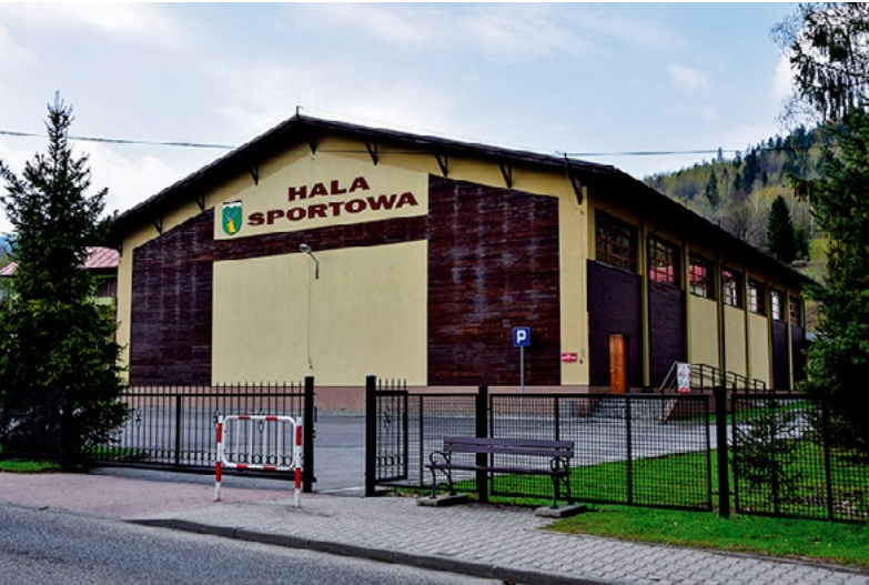
Hala Sportowa przy Szkołe Podstawowej w Korbiewie zbudowana w latach 2006–2009 (fot. 2017)
