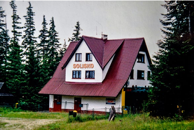
Schronisko „Solisko” na Solisku Mazurowym i jednocześnie dolna stacja wyciągów zaczepowych nr III i IV. Zostało wyburzone w 2013 r. (fot. 1997)
