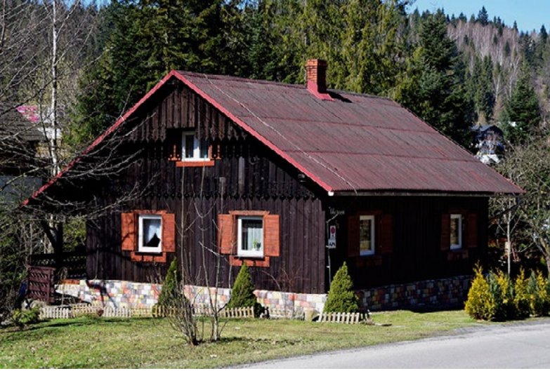
Gajówka w Korbielowie Kamiennej, przy potoku Szczyrbok, wzniesiona w 1905 r. w miejscu wcześniejszej (fot. 2017)
