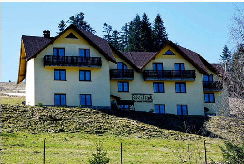
Górski Ośrodek Wypoczynkowy „Polonina” w Korbielowie Kamiennej (fot. 2017)
