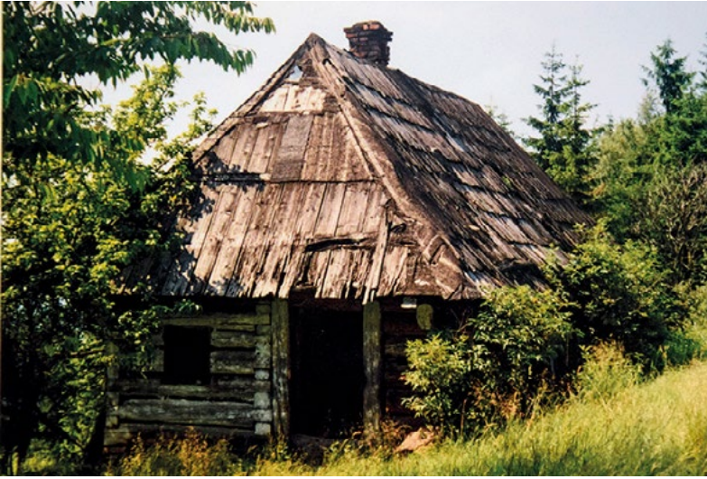
Chałupa (z czterospadowym dachem) z pierwszej połowy XIX wieku na Przełęczy pod Beskidem (Sedło pod Beskydom) (fot. 1998)
