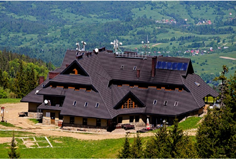
Schronisko PTTK na Hali Miziowej zbudowane w latach 1987–2003 (fot. 2017)
