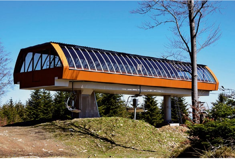
Górna stacja wyciągu krzesłkowego z Ośrodka Wypoczynkowego „Pilsko-Jontek” na Buczynkę (fot. 2017)
