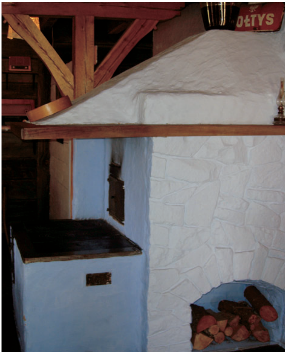
Ilustracja 28. Daszek nad płytą w piecu kuchennym do pochłaniania dymu i odprowadzania oparów powstałych podczas smażenia lub gotowania
