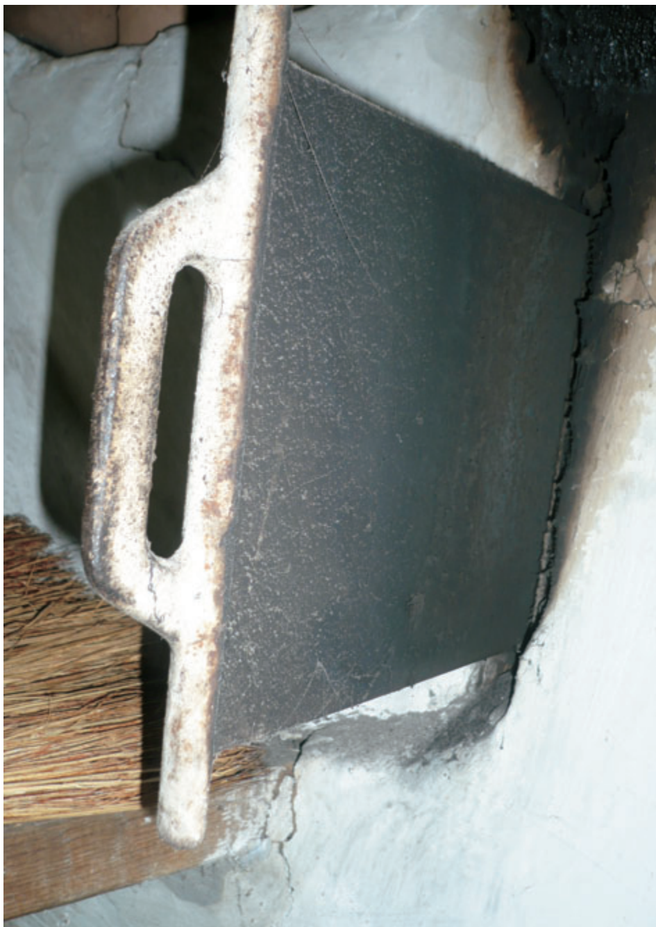
Ilustracja 31. Zasuwa do przemykania kanału kominowego w celu regulacji ciągu Nazwy: lucht, luft, szyber, szyberek.
