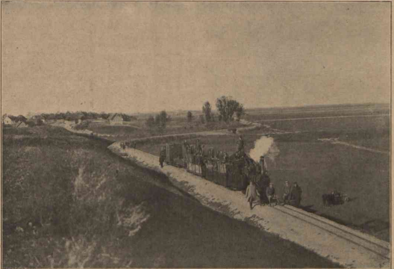
Budowa Pińczowskich Kolei Dojazdowych (układanie nawierzchni) w r. 1926.
