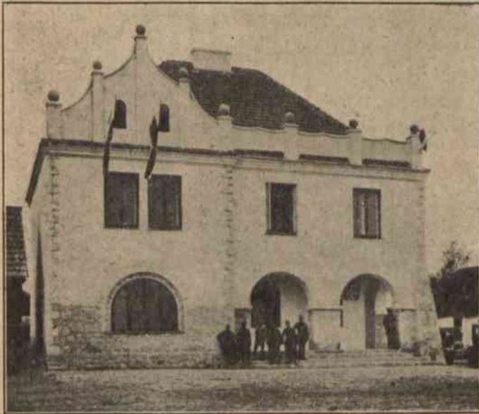
Budynek Urzędu gminnego w Olsztynie, wybudowany w 1927 r.
