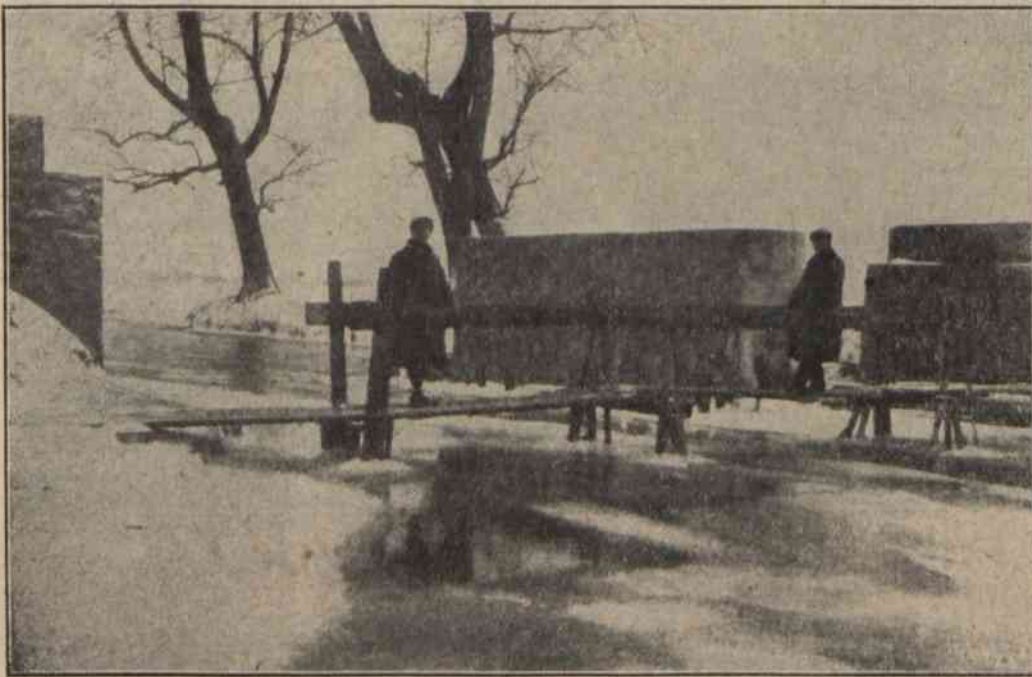
Budowa mostu żelazno-betonowego na rzece Rawce, przez Mag. m. Rawy M.
