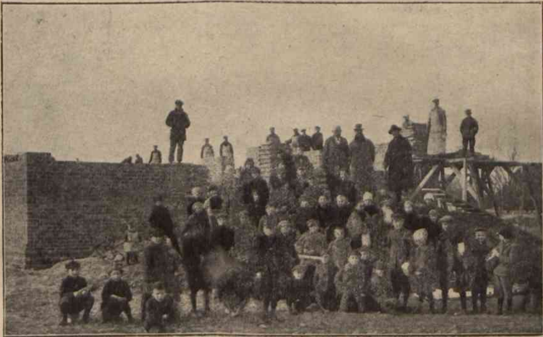
Budowa szkółki powszechnej w Grodzisku.
