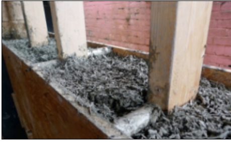
Ryc. 2. Kompozyt wapienno-konopny ubijany w szalunku. Źródło: https://www.konopie.info.pl/zastosowanie/budowanie-z-konopi/
