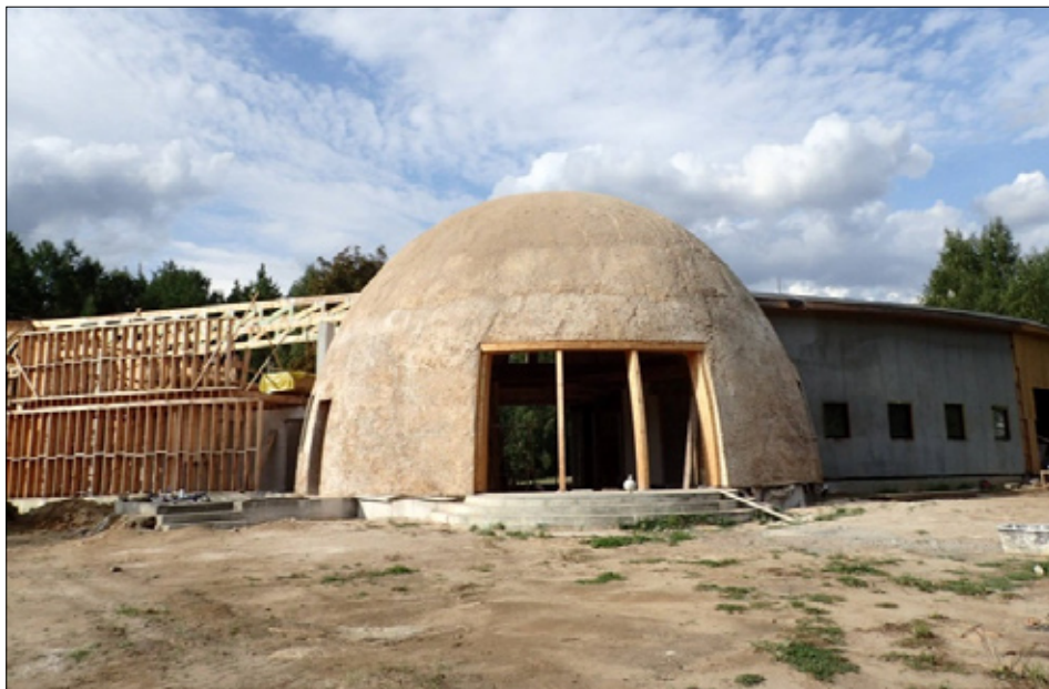
Ryc. 5. Największa w Polsce kopuła mieszkalna 14 m średnicy, grubości przegrody 40 cm pierw- sza w Polsce wypełniona metodą natryskową betonem konopnym.
