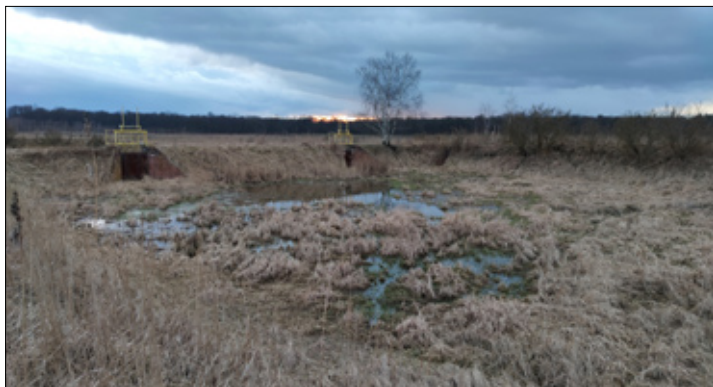
Fot. 5. Osadnik w północnej części pól irygacyjnych częściowo zalany wodą. Fot. Krzysztof Kolenda
