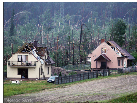
Ryc. 7. Skutki trąby powietrznej, która w dniach 15-16 sierpnia 2008 roku przemieszczała się od okolic Strzelc Opolskich po Piotrków Trybunalski. Źródło: www.gazeta.pl , dostęp: 21.08.2008).
