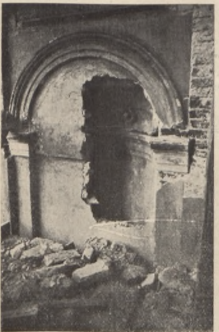
Wnęka odkryta w pawilonie bocznym — na wysokości I-go piętra
