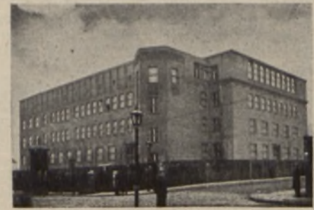
Warszawa Szkoła przy ul. Rozbrat
