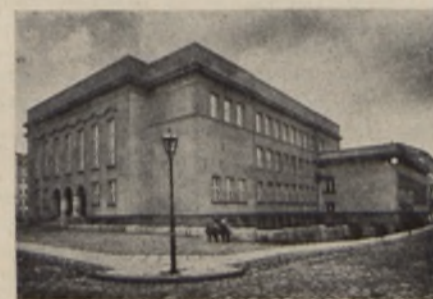
Warszawa Szkoła przy ul. Rozbrat
