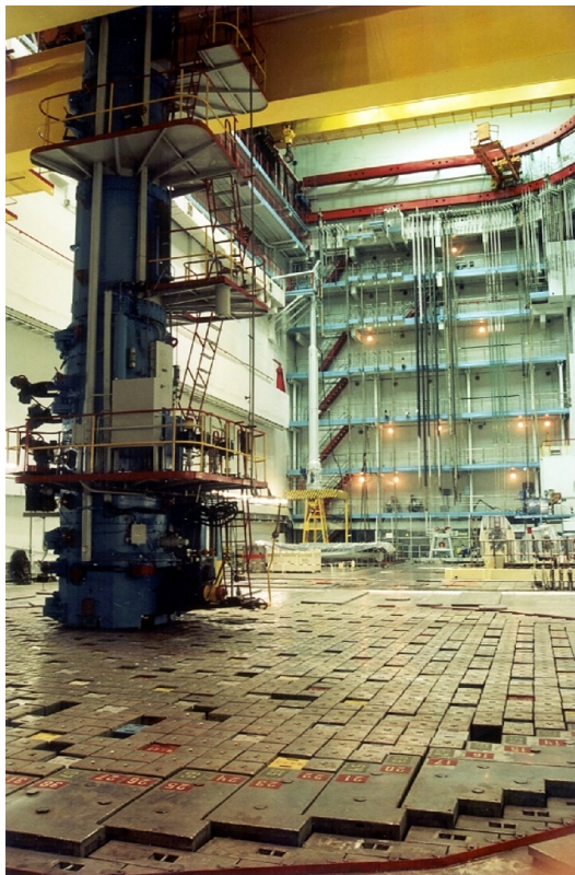
Fot. 1. Widok hali z maszyną przeładowniczą reaktora RBMK w elektrowni jądrowej Smoleńsk.
