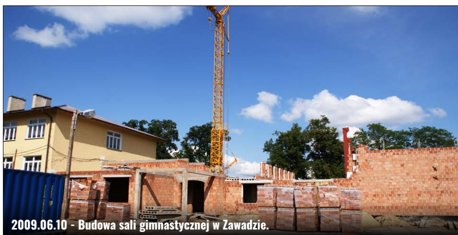
2009.06.10 - Budowa sali gimnastycznej w Zawadzie.
