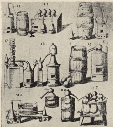
Abb. 14. Chemische Kühlvorrichtungen des 16. Jahrhunderts. (Mylius, „Basilica“).
