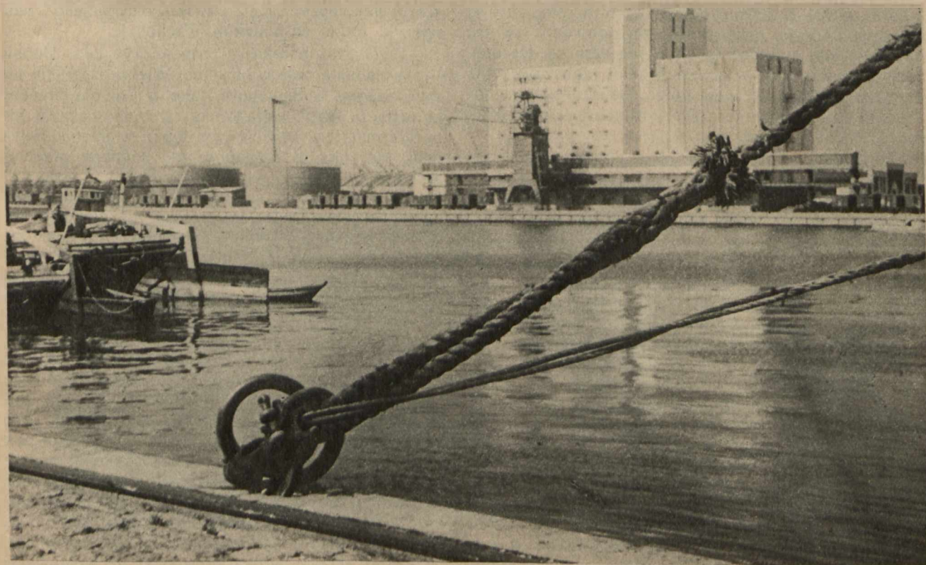
Fragment basenu im. Marszałka Piłsudskiego w Gdyni. W głębi elewator zbożowy
