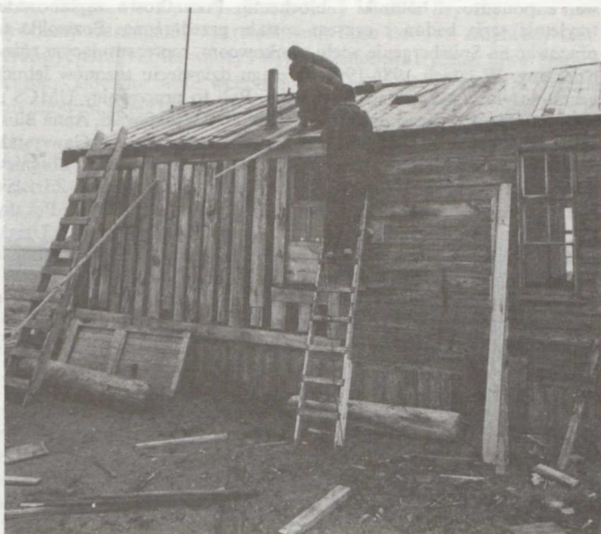
Całodobowa akcja „Dach” – nasz dom musi być przecież suchy i ciepły (fot. autorka)
