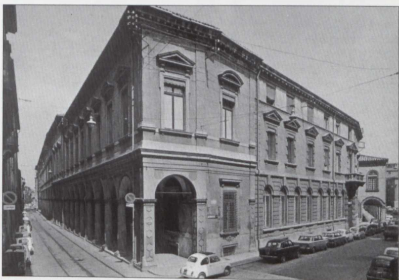
Palazzo Poggi – jeden ze starszych budynków uniwersyteckich
