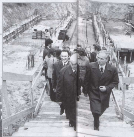
Wmurowanie aktu erekcyjnego pod gmachów Rektoratu, Wydziału Ekonomicznego oraz Wydziału Prawa i Administracji
