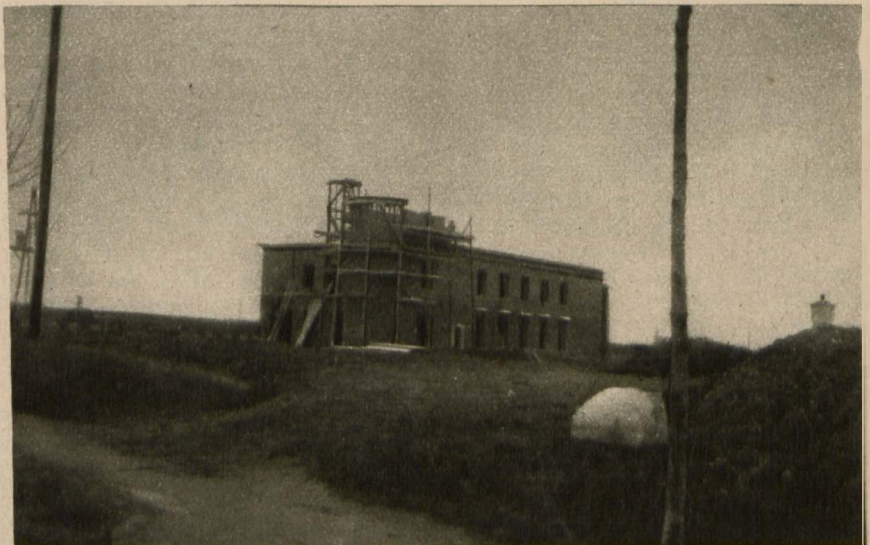
Obecny stan budowy „Domu Rybaka” w Wielkiej Wsi
