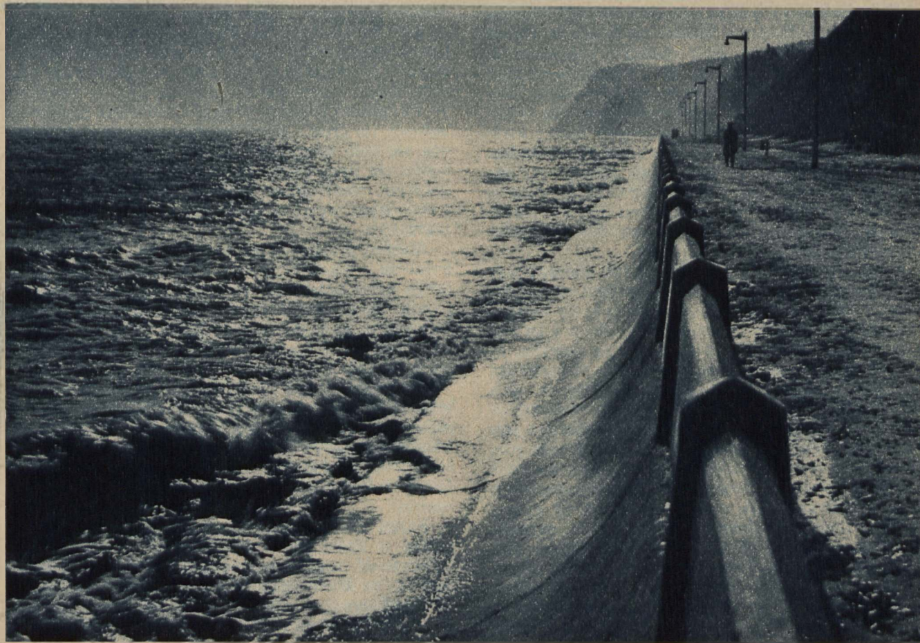
Betonowe umocnienia nabrzeża pod Kamienną Górą
