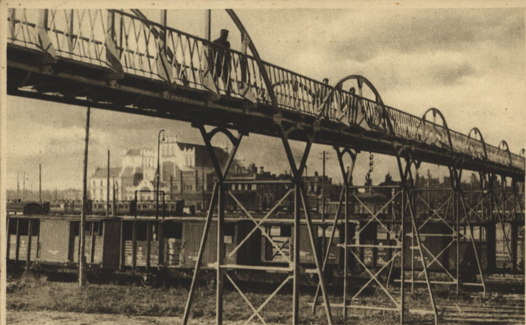
BRZEŚĆ n/B. Wiadukt kolejowy.
