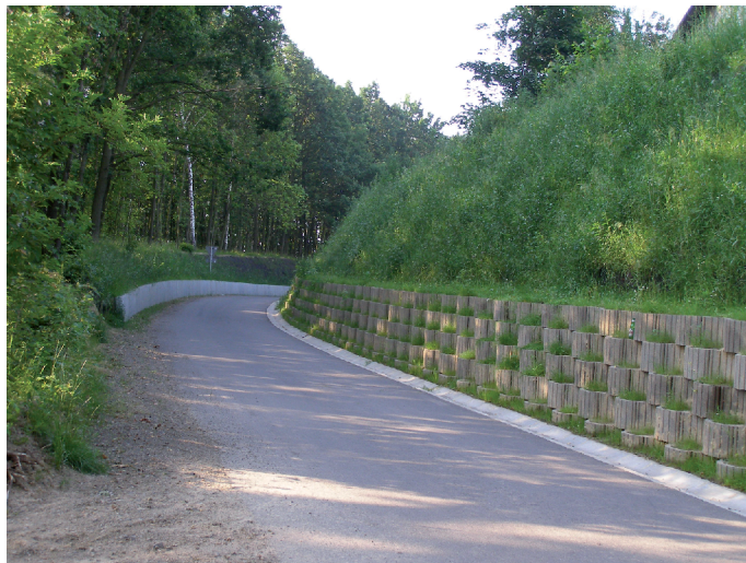
Fot. 4. Nawierzchnia bitumiczna w wąwozie drogowym w rejonie Dysa Bitumastic surface in the bottom of the road gully near Dys
