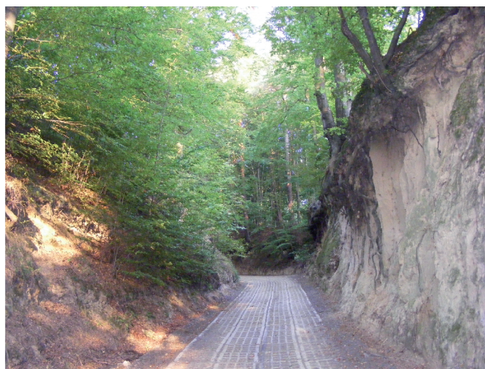
Fot. 5. Utwardzenie dna wąwozu drogowego w rejonie Modliborzyc płytami typu YOMB Stiffening of the bottom of the road gully near Modliborzyc using YOMB pavers
