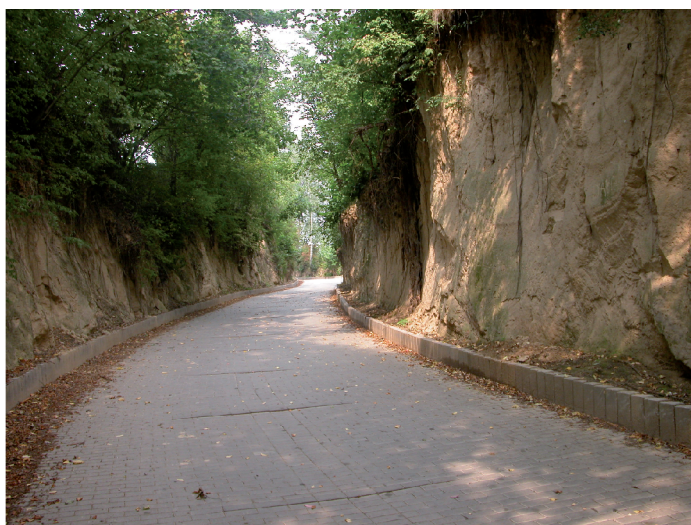
Fot. 6. Dno wąwozu drogowego w rejonie Rogowa utwardzone kostką cementową Bottom of the road gully near Rogów stiffened with cobblestones
